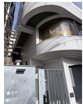
正面左の階段を上って2階事務所へ
